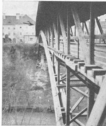
Abb. 3. Bogenquerschnitt 1:50 Abb. 2. Streifbild mit Ausknickung
