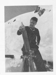
Abb. 32. Minenwerfer zur Lawinen-(Phot. Meerkämper) auslösung
