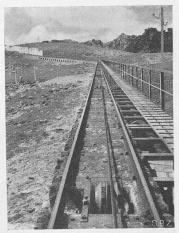
Abb. 6. In einer Minimalkurve Abb. 7. In der Geraden Oberbau der Giesserei Bern, v. Rollsche Eisenwerke
