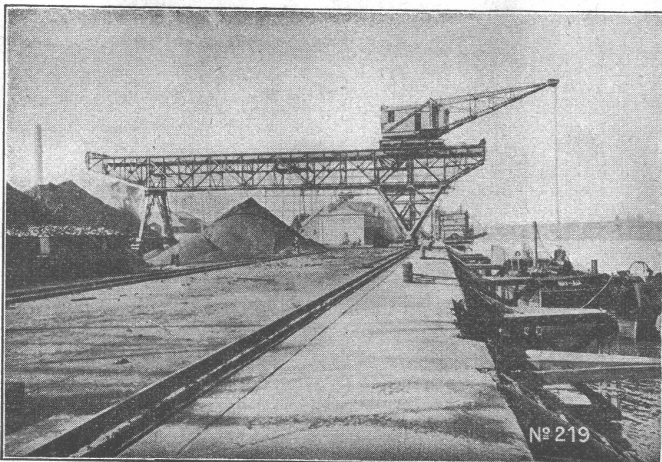
Verladeanlage im Hafen von Bilbao.
