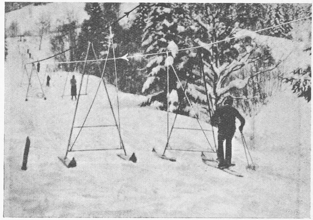
Abb. 1. Skilift in Flühli (Entlebuch) nach System Wullschlegler, bergwärts gesehen (weisses Zugseil bergwärts ziehend)
