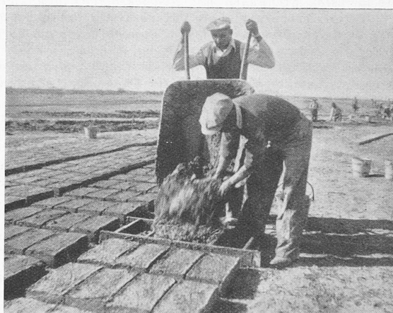
Abb. 18. Herstellung der «Adobe»-Ziegel
