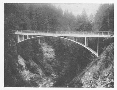
Abb. 3. Talseitige Ansicht, Stützweite 37,4 m, Pfeilhöhe 6,0 m, Gewölbestärke 20 cm
