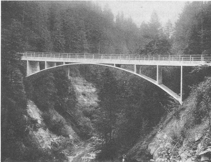
Abb. 3. Talseitige Ansicht, Stützweite 37,4 m, Pfeilhöhe 6,0 m, Gewölbstärke 20 cm
