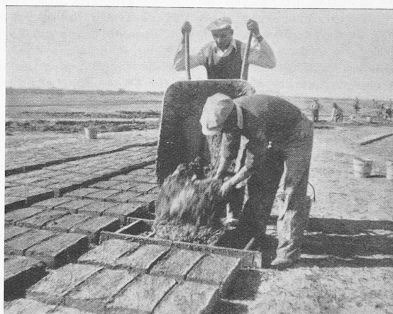
Abb. 18. Herstellung der «Adobe»-Ziegel
