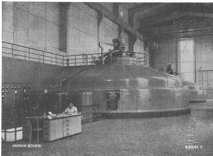
Aarewerke A. G., Zentrale Klingnau. - Teilansicht des Maschinensaales mit zwei von den drei gelieferten Dreiphasengeneratoren je von 19500 kVA, 10500 V, 75 U/min, 50 Per/s.
