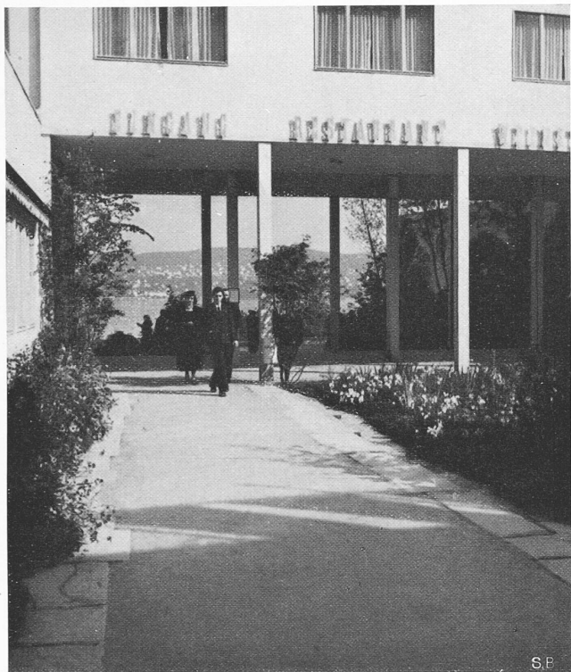
Abb. 16. Blumenhof und Durchblick beim Zugang zum Hotel (links)
