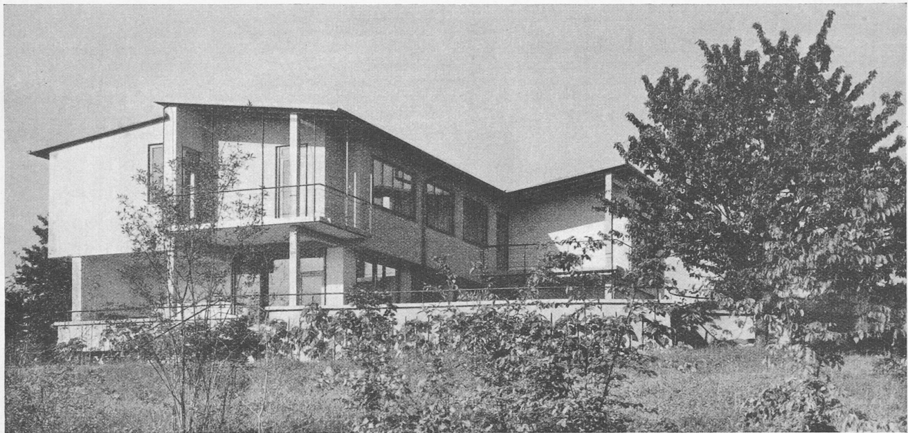
Wohnhaus Sch. in Zollikon. — Arch. WERNER M. MOSER, Zürich. — Ansicht der Gartenseite aus Südwest
