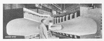
Abb. 8. Saugrohr aus Holz und Gips für Modellversuche Abb. 9 (links). Modellversuchsanlage mit Luftbetrieb zur Ermittlung von Berechnungs- und Konstruktionsunterlagen für eine 115000 PS Wasserturbine
