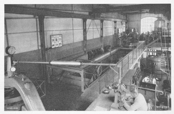
Abb. 2. Das hydraulische Versuchslokal für Niederdruck- und Kavitationsversuche von Escher Wyss, Zürich (vrgl. «SEZ» Bd. 80, S. 235\*)
