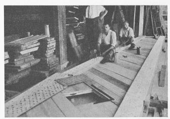
Abb. 14. Nagelung der einzelnen Binderteile in der Werkstatt
