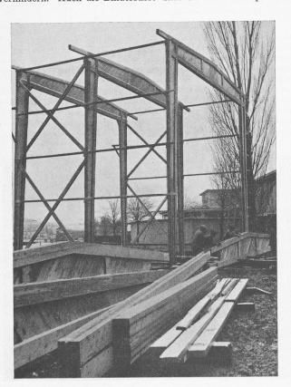
Abb. 15. Zusammenbau der genagelten Binderteile
