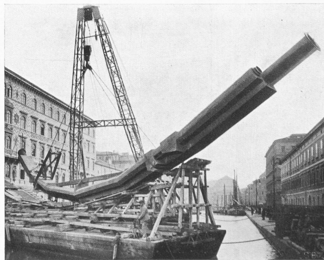
Abb. 2. Eisenbeton-Dücker von 40 t, fertig versetzt in eine Kanalsole Entwurf von Ing. LUDW. GSCHWEND, G. E. P. (von St. Gallen) in Triest
