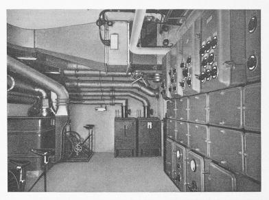
t Abb. 2. Teilansicht des Maschinenraumes eines Gasschutzkellers für 300 Personen. Links LUWA-Gasfilter mit vier Veloantrieben, die für die Belüftung genügen. Im Hintergrund zwei methodische CO<sub>2</sub>-Absorbiergeräte, System LUWA. An der Decke Luftkanal für die Konditionierung der Luft, mit eingebauter Kühl- bezw. Heizbatterie.
