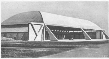
Abb. 5. Flugzeughalle aus Eisenbeton. Arch.-Ing. PIER LUIGI NERVI
