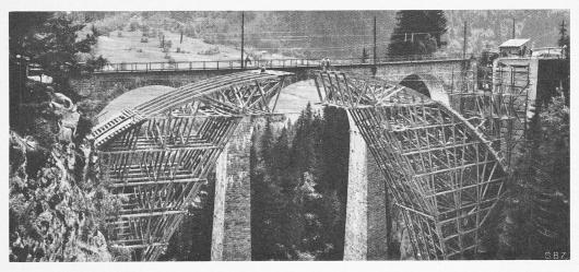
Abb. 8. Lehrgerüst im Freivorbau zum Scheitelschluss bereit (15. Juni 1938)
