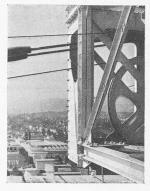
Abb. 33. Tragseile, darüber Hilfseil, darunter Zugseil
