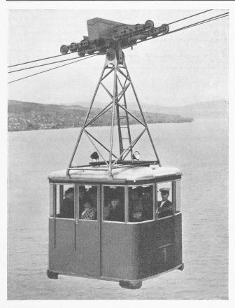
Abb. 31. Eine Kabine mit ihrem sechzehnrädrigen Laufwerk
