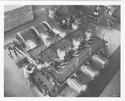
Abb. 1. Hochdruck-Umkehr-Dampfmaschine. Photo DEMAG, Duisburg
