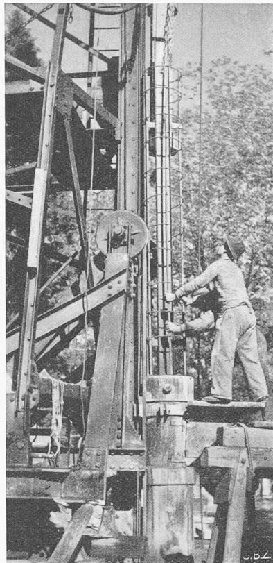
Abb. 14. Einführen der Armierung in das Pfahlrohr, System Züblin
