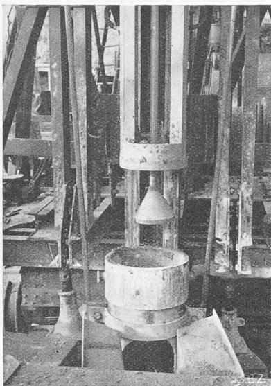
Abb. 15. Betoneinwurf in das Pfahlrohr und Stössel
