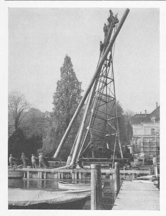
Abb. 11. Ausführung der Franki-Pfahlfundation am linken Ufer durch LOCHER & CIE., Zürich
