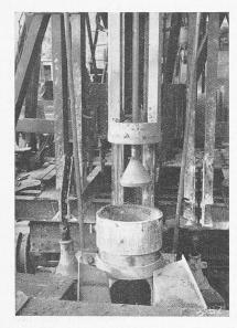
Abb. 15. Betoneinwurf in das Pfahlrohr und Stössel
