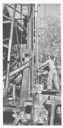
Einführen der Armierung in das Ptahlrohr, System Züblin
