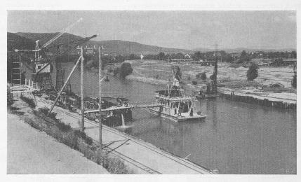
Abb. 13. Flussabwärts gegen r. Ufer, Caisson-Batterie für Dienstbrücken-Pfeiler 1 (2. Aug. 38)
