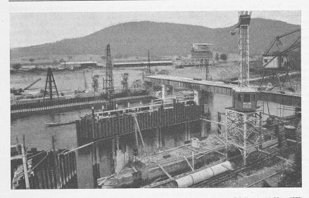
Abb. 15. Flussaufwärts gegen rechtes Ufer, Spundwandumschliessung Pfeiler 1 (14. Nov. 1938)
