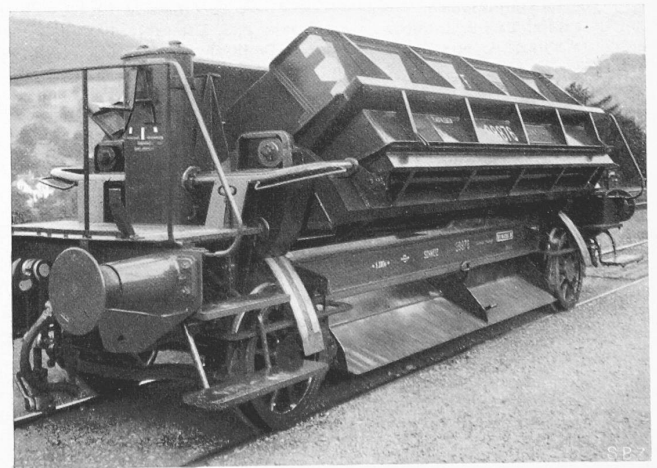
Abb. 18. Universalkippwagen Pat. Ochsner der SBB, erbaut von der Schweiz. Industrie-Gesellschaft Neuhausen
