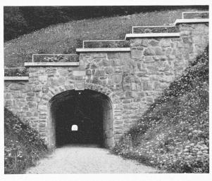
Abb. 4. Tunnel 3,0 m br., 192 m lg., mit zwei Ausweichstellen von je 5,0 m Breite. — Güterweg Gräpplang-Fäsch
