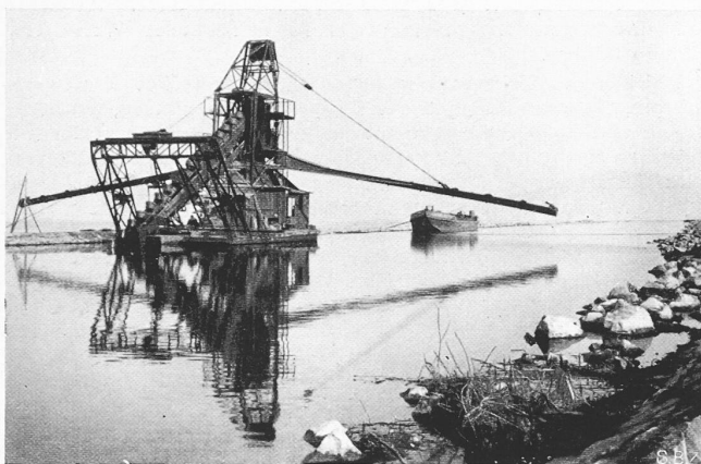
Fig. 4. Dragage flottant dans le chenal du Grand Canal
