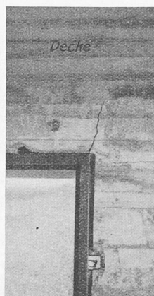
Abb. 11. Riss in einem Türsturz
