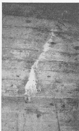
Abb. 9. Riss in Gehweg-Auskrägung einer Eisenbetonbalkenbrücke mit Sinterbildung
