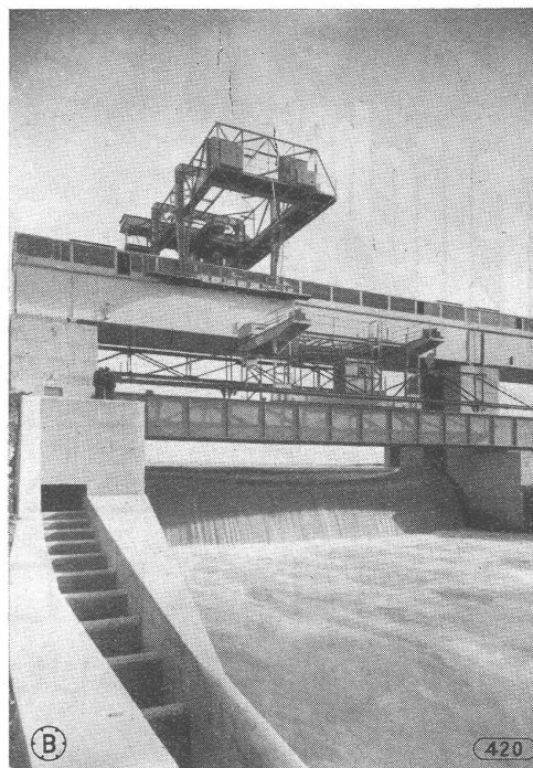
Wehranlage Klingnau, Ansicht von Unterwasserseite mit Dambalkenkrane
