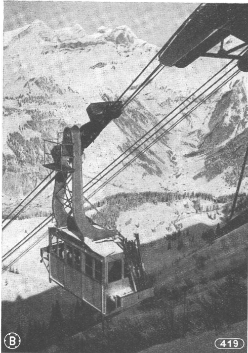
Luftseilbahn Gerschnialp-Trübsee (Umgebaut 1937/38 durch Giesserei Bern)
