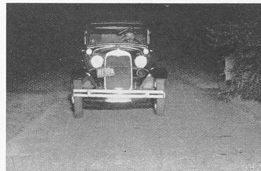
Abb. 2. Vermeidung der Blendwirkung bei vollem Polaroid-Scheinwerferlicht, Aufnahme durch Polaroidfenster
