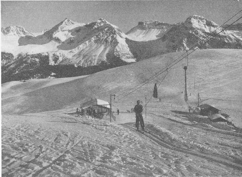
Abb. 11. Blick südöstlich auf die Antriebstation und (im Hintergrund) die Mayenfelder Furka, rechts Gehänge mit Gürteln und Schleppseilen auf dem Rücktransport
