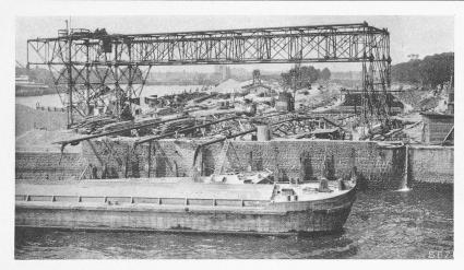
Abb. 13. Caissonabsenkung am rechten Ufer; dahinter Rampentunnel im Bau
