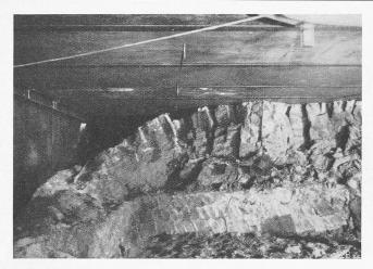
Abb. 9. Der Ton des Arbeitskammerbodens wölbte sich unter dem Schub der sinkenden Caissonschneiden stellenweise bis zur Kammerdecke im U
