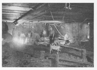
dem Abb. 8. Blick in die Arbeitskammer während der Entfernung der Betonfundamente unter den Schneiden und der 90 Holzpfähle, die sich im Untergrund vorfanden. Zwischenschneide mit Durchgang und Stahlhülle erkennbar
