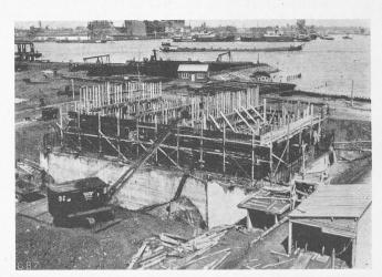
Abb. 10. Absenkung des Caisson am linken Ufer mittels offener Wasserhaltung. Der Aushub wird unter der landseitigen Schneide durchgeworfen
