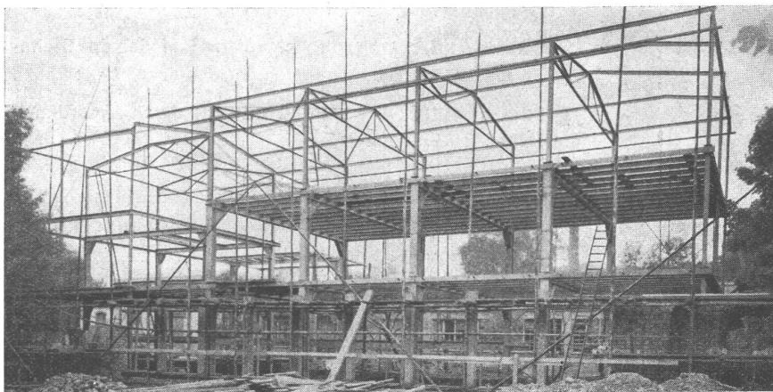
Stahlskelett des Laboratorium-Gebäudes der Aluminium-Industrie A.G., Neuhausen, von uns **ohne Mittelstützen** projektiert und ausgeführt.
