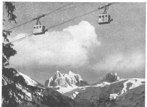
Luftseilbahn Gerschnialp-Trübsee mit Spannörtern
