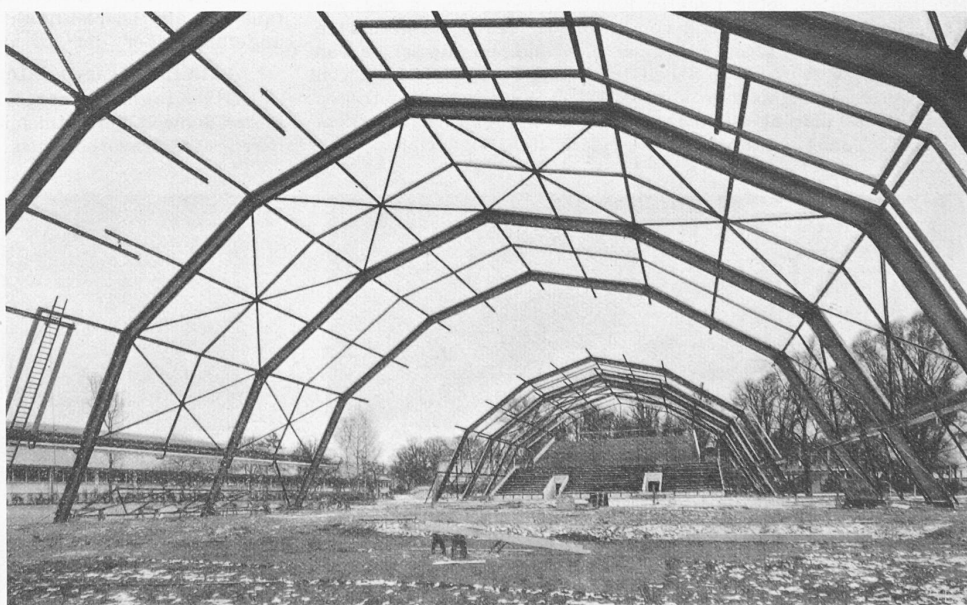
Abb. 54. Festhallen-Zeltdach [62] mit den längsverschieblichen zwei Mittelstücken, im Bau
