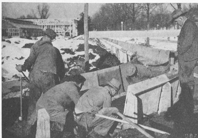
Abb. 33. Bau des Schifflibaches aus Eisenbeton-Elementen
