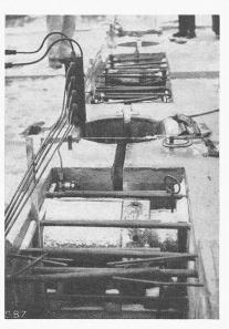
Abb. 6. Scheitelfuge nach dem Aufpressen. Im Vordergrund eine 330 t-Presse
