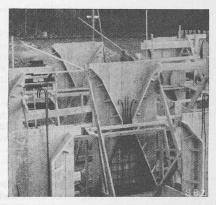
Abb. 15. Armierung der seitlichen Stützen
