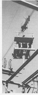
Abb. 2. Umsetzen des Betontrichters. Beim Betonieren ruht er mittels der beiden I auf dem Lehrgerüst und dient zugleich als Silo für das Quantum von rd. 1 m3, das ihm mit jedem Spiel des Kabelkrans zugeführt wird
