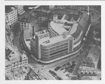
Abb. 5. Fliegerbild des Warenhauses Jelmoli, Zürich; der nach dem Steinmühleplatz und der Uraniastrasse liegende Neubau hat Decken-Heizung und -Kühlung. Mit schwarzem Pfeil und Streifen sind die gekühlten, mit weissem Pfeil und Streifen die ungekühlten Räume bezeichnet, deren Temperaturverhältnisse im Text erläutert sind
