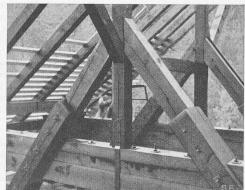
Abb. 11. Zugfester Anschluss der Portalstreben
