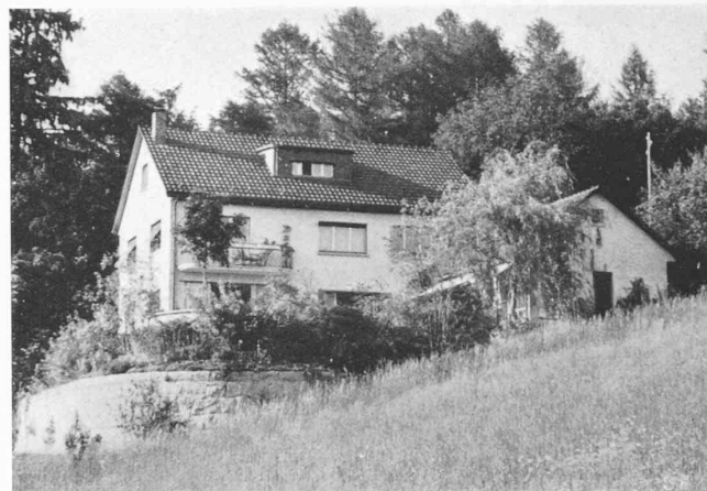
Abb. 15. Haus und Gartenterrasse aus Süden
