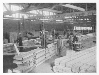
Abb. 9. Fabrikmässige Herstellung der Bindersegmente
