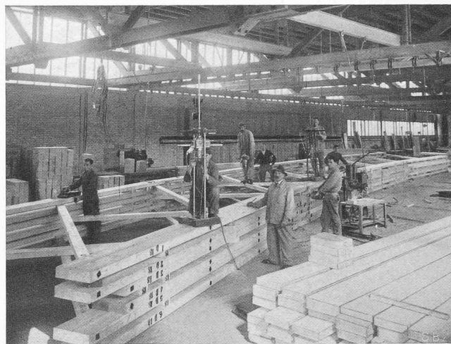
Abb. 9. Fabrikmässige Herstellung der Bindersegmente
