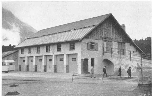
Abb. 54. Postauto- und Schneebruchmaschinen-Garage Maloja, Umbau
