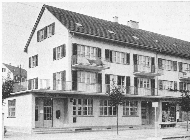
Abb. 43. Postbureau Oberwinterthur, Mietlokal in einem Neubau
