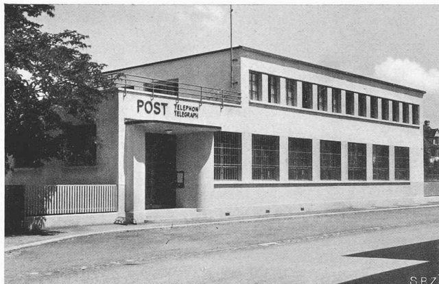
Abb. 30. Postgebäude Wallisellen, Strassenseite
