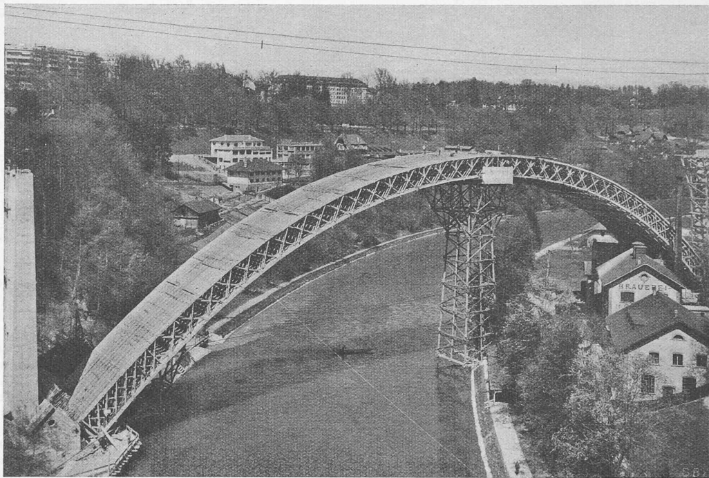
Lehrgerüst der neuen SBB-Aarebrücke in Bern. Stützweite 146,5 m. Erbauer LOCHER & CIE., Zürich Der Gerüstturm in der Mitte diente lediglich zur Montage und ist heute abgebrochen
