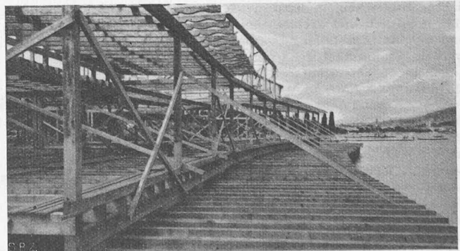
Abb. 46. Seeterrassen im Bau (am 17. Aug.) mit Blick auf die Stadt
