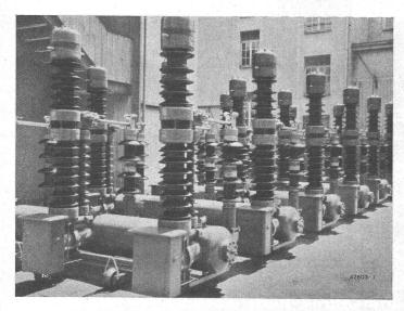
Eine Serie ablieferungsfertiger Druckluft-Schnellschalter für Freiluftaufstellung, 640 Amp., Nennspannung 87 kV, Abschaltvermögen 1000 MVA bei 74 kV wiederkehrender Spannung.
