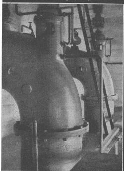
Vertikal-Propellerpumpe 30 000 lit/min
