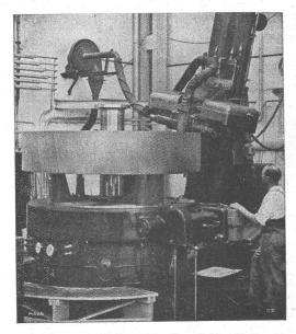
MAAG-Zahnradschlelfmaschine Type H SS-4 für Durchmesser bis zu 3,6 m. Die grösste Zahnradschlelfmaschine der Welt.
