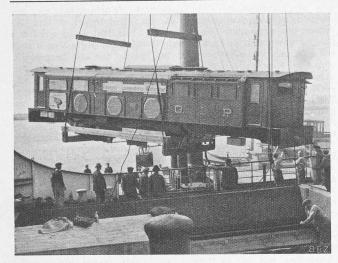
Abb. 2. Verladen der G. I. P.-Lokomotive der SLM Winterthur vom Bahngeleise auf das Schiff in Antwerpen
