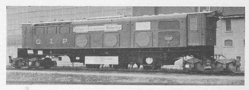
Abb. 1. Bahn-Transport einer für die Great Indian Peninsula Ry. gebauten elektr. Breitspurlokomotive aus den Werkstätten der Schweiz. Lokomotiv- und Maschinenfabrik Winterthur nach Antwerpen
