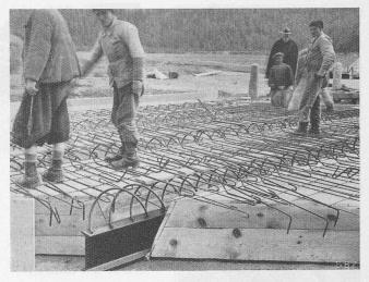
Abb. 20. Alpha-Armierung der Inn-Brücke Sils-Baselgia
