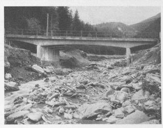
Abb. 24. Plattenbalken-Brücke im Val Ruinains, Unterengadin
