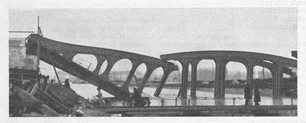
Abb. 2. Die am 14. März 1938 eingestürzte 74,5 m lange Strassenbrücke bei Hasselt, Belgien
