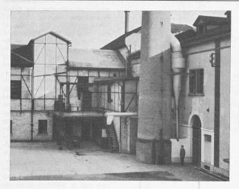
Abb. 6. Einfach-Zyklon van Tongeren, in einer Brauerei
