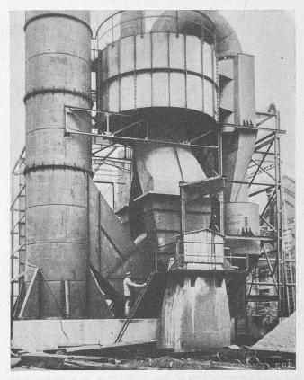
Abb. 12. Doppelabscheider, 252 kg/h Staub, Entstaubungsgrad 87%
