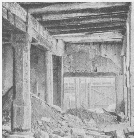
Abb. 2. Eichene Säule und Gebälk in der Arkade
