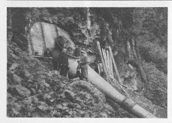
Abb. 2. Uebergang vom Druckstollen zur Rohrleitung
